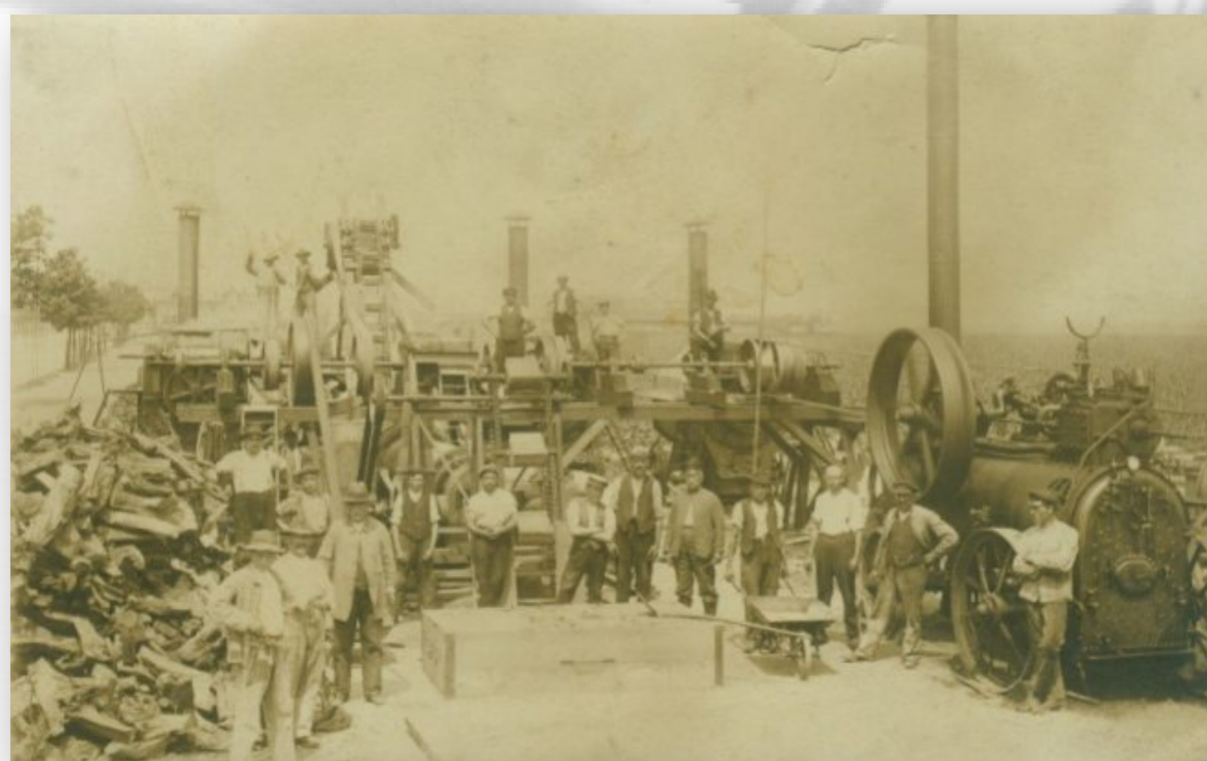
Bauarbeiten an der Opel-Rennbahn 1917 bis 1919
