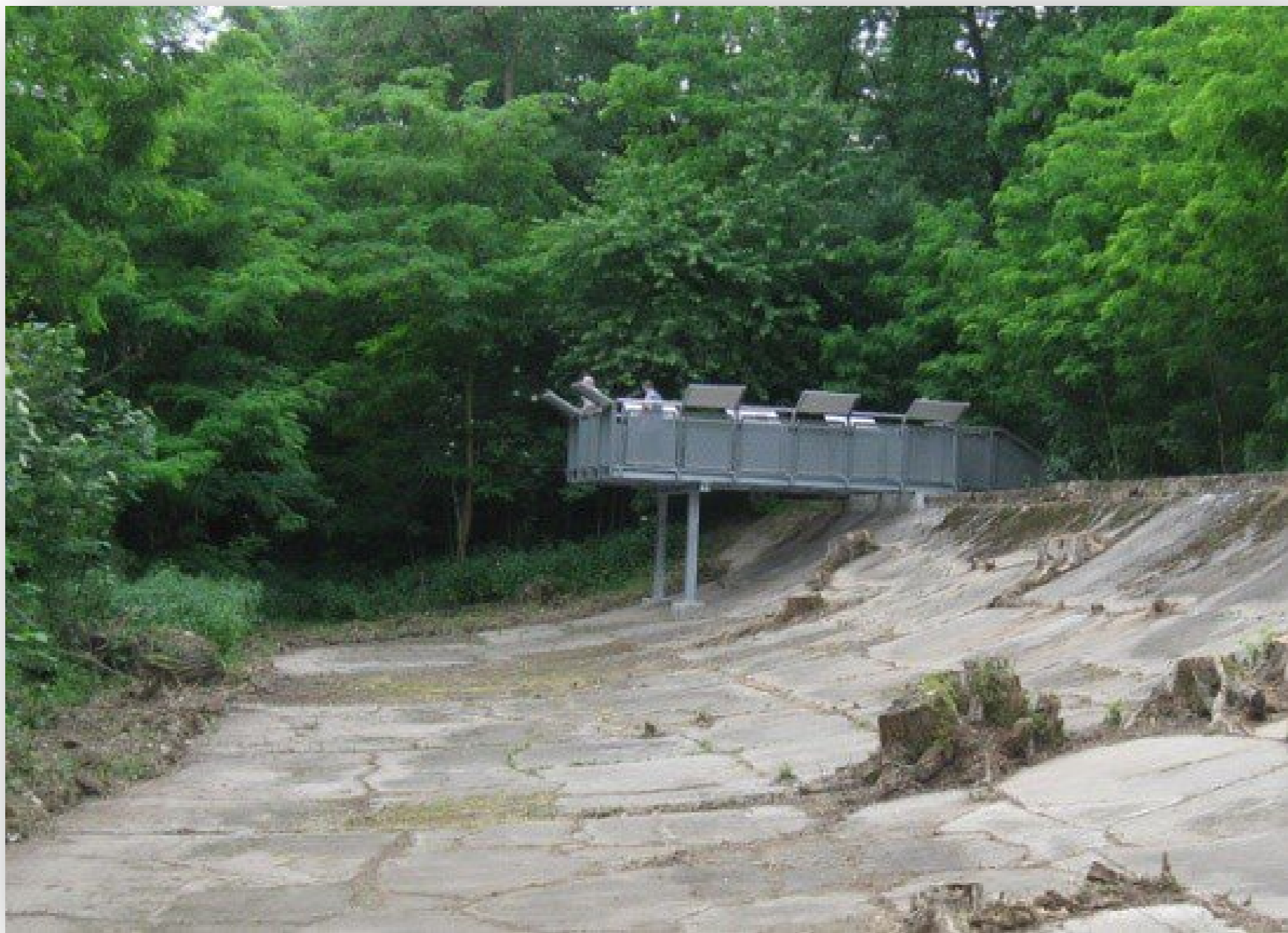
Besucher-Plattform (Stahlkonstruktion) an der Nordkurve der Opelbahn, 2013
