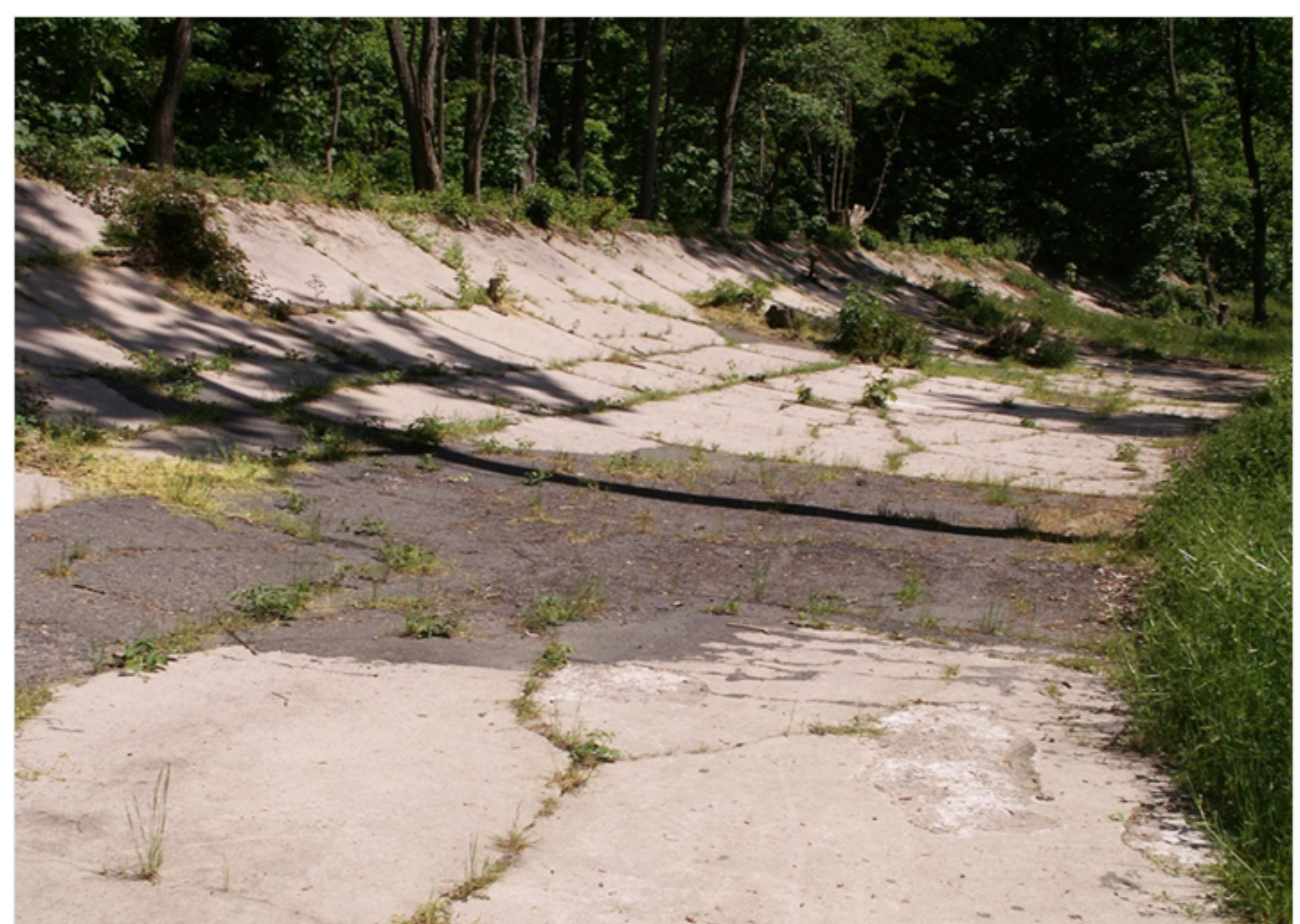
Zustand der Opelbahn 2019
