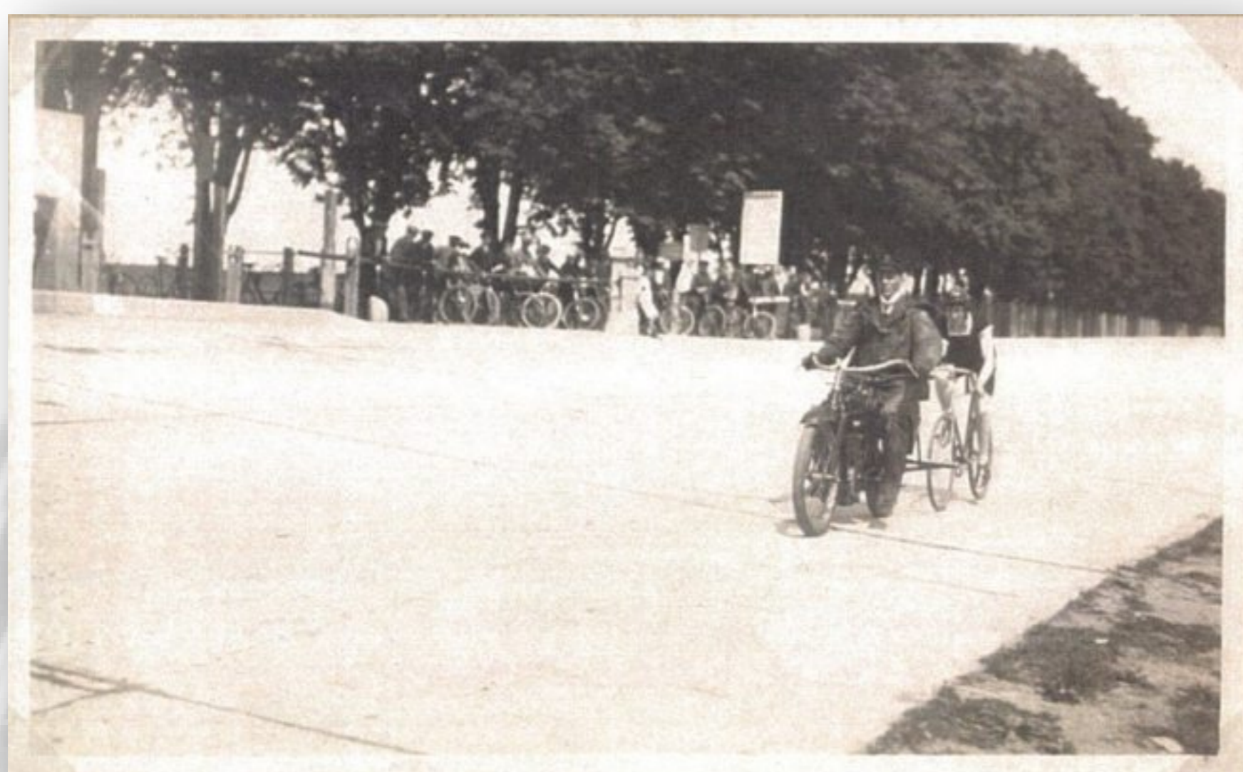
Steherrennen auf der Opel-Rennbahn
